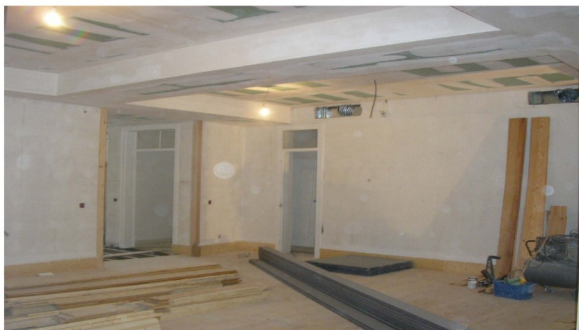
CONCLUSÃO DA REMOÇÃO DA PAREDE E DA INSTALAÇÃO DAS VIGAS DE MADEIRA LAMELADA COLADA
