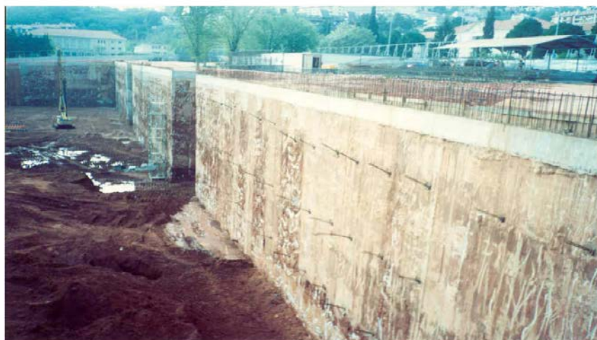
FOTOGRAFIA DUMA PAREDE MOLDADA ANCORADA, COM 21,5M DE ALTURA
