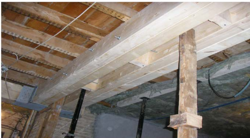
VIGAS DE MADEIRA LAMELADA COLADA RESSALVANDO O VÃO DUMA PAREDE QUE FOI DEMOLIDA
