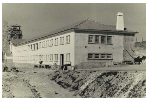
Fotografia de cerca de 1952, das obras do pavilhão de infetocontagiosos, na qual se pode observar a torre da capela prisional ainda em construção.
