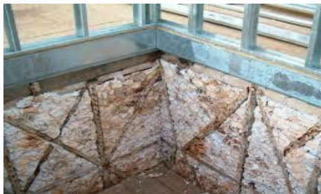
Em edifícios mais recentes, assegurada por estrutura reticulada de pilares e vigas, em aço ou em betão armado, e lajes em madeira, ou em aço, ou mistas em aço e betão.
