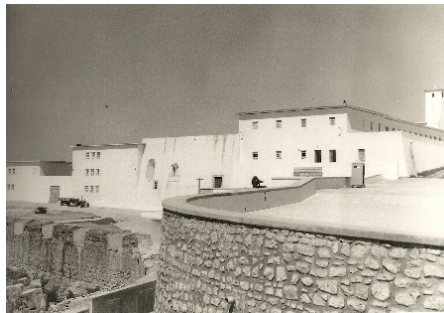
47 – Cadeia do Forte de Peniche, depois das obras de beneficiação, c. 1947. Fundo Fotográfico do Arquivo da DGRSP
