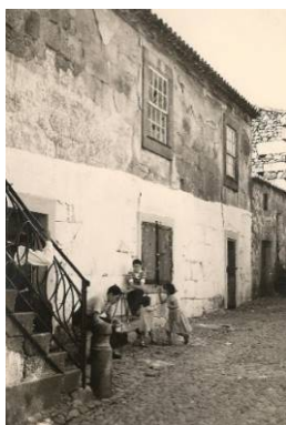
23 - Cadeia Comarcã da Meda, instalada em edifício civil, demarcada pela pintura em branco, 1959. Fundo Fotográfico do Arquivo da DGRSP
