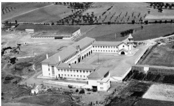
53 - Estabelecimento Prisional de Izeda, instalado na extinta Escola Profissional de Santo António (Colónia Correccional de Izeda) para menores, 1960. Fundo Fotográfico do Arquivo da DGRSP.
